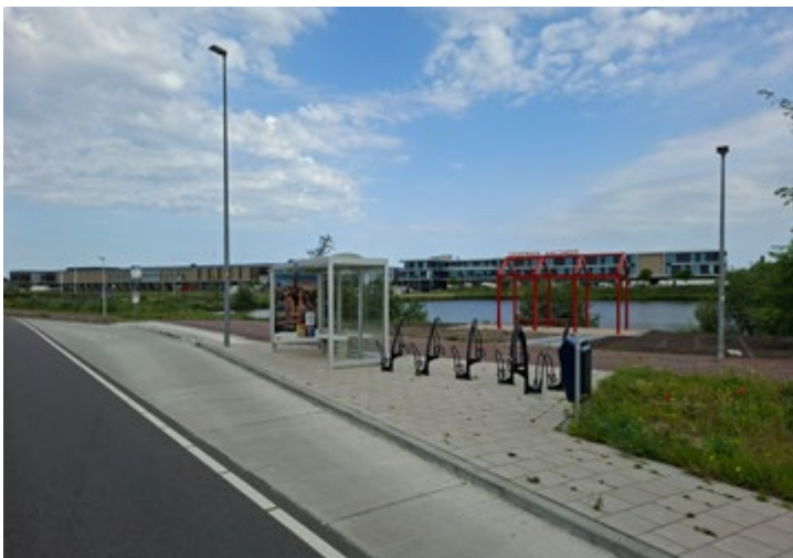
De bushaltes met fietsenstalling aan de Machineweg zijn aangelegd.
