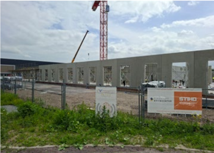
Voortgang bouw Hilton-Hotel: de fundering is aangelegd en de betonnen constructie van de begane grond staat. De opening is voorzien in 2028.
