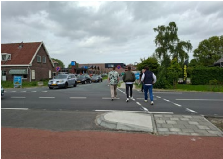
De herinrichting van de Aalsmeerderweg is klaar: toegang tot de nieuwe Hoogvliet supermarkt.
