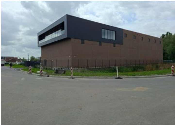
Het nieuwe opslag- en distributiecentrum voor Clarijs Fine Wine Selections is recent opgeleverd.
