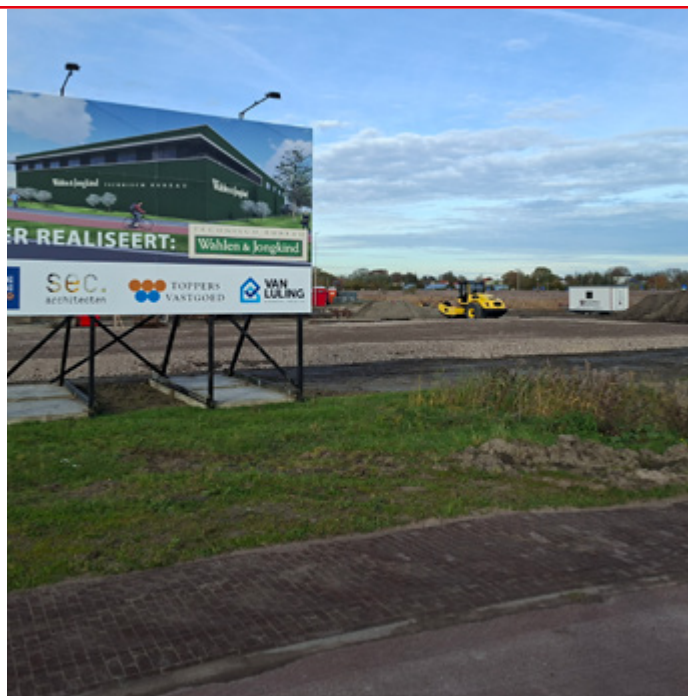
Bouwlocatie en bouwboard Toppers Vastgoed
