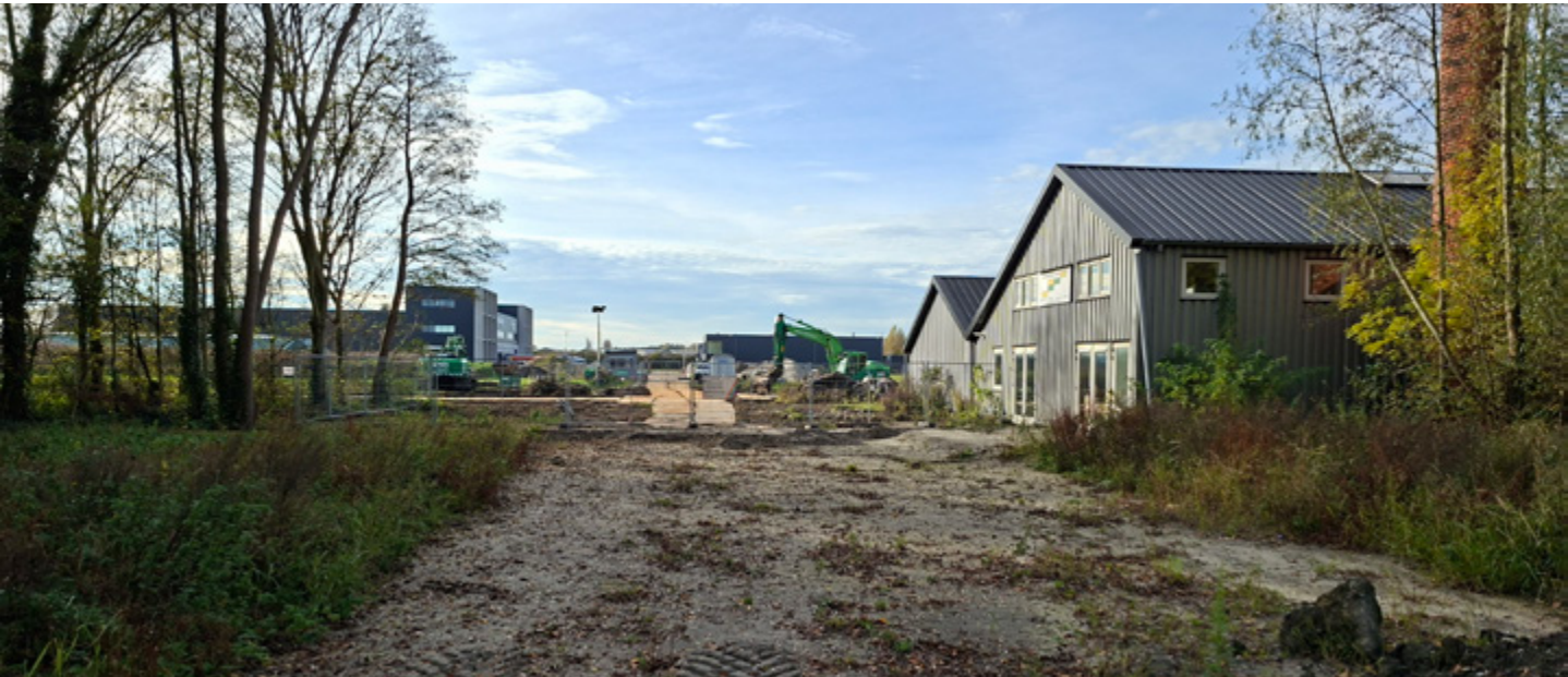
Werkzaamheden Samoaweg (sanering van grond)
