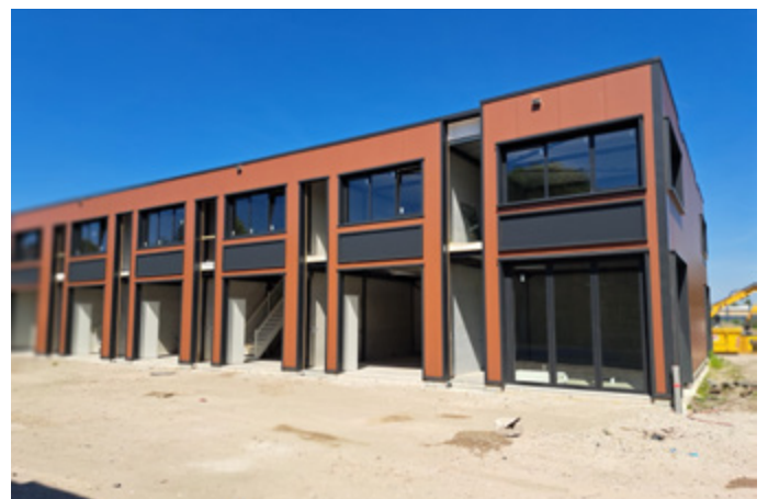
De bedrijfsunits in aanbouw
