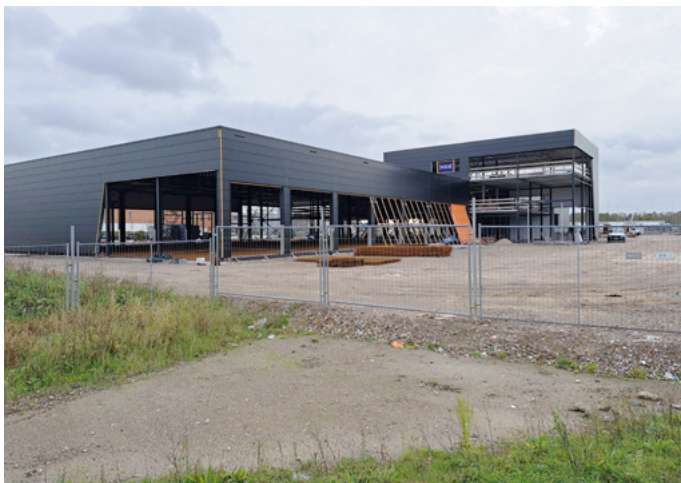
Start bouw garage Mercedes
